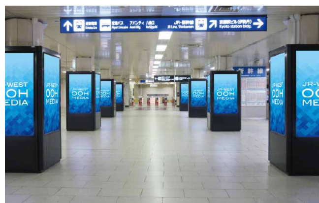
地下鉄連絡口のコンコースに設置された柱巻きディスプレイ
