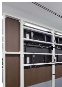
10台のディスプレイを支える鉄骨製のオリジナル自立スタンド
