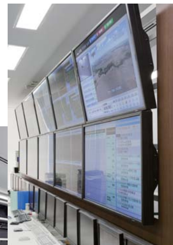
10台のディスプレイを支える鉄骨製のオリジナル自立スタンド
