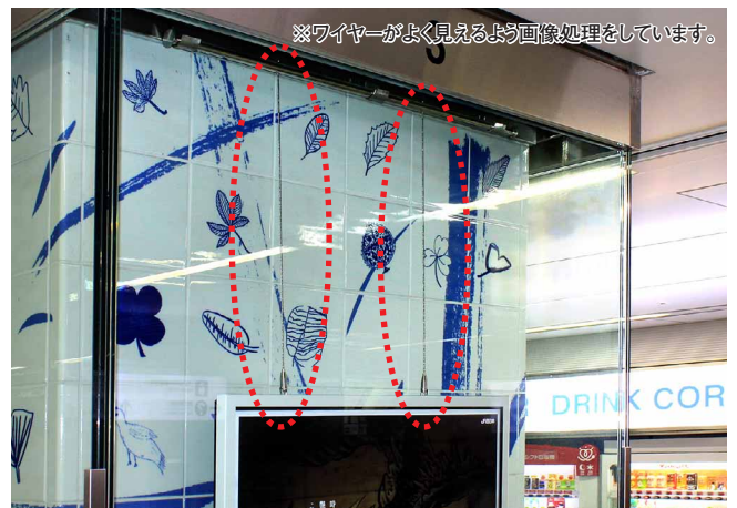
薄型・軽量のため、狭いガラススキン内にすっきり収まり、2本のワイヤーだけでの吊り下げ設置が可能に
