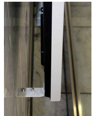
下部はディスプレイの傾きを支える簡素な金具のみ
