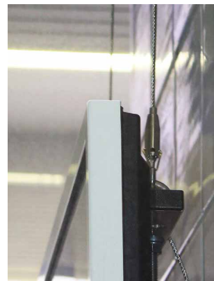
電照広告を吊り下げていたワイヤーをそのまま活用
