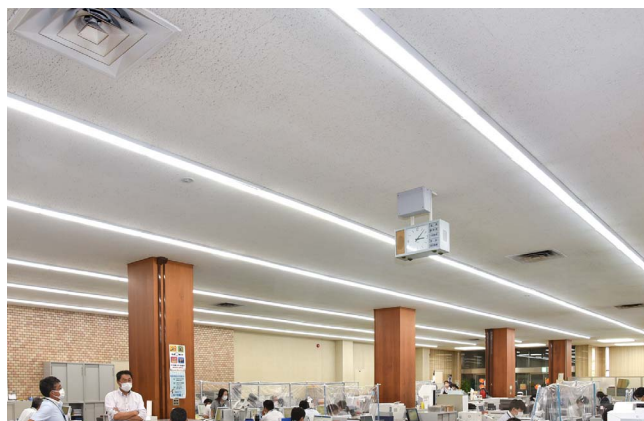
本店でも蛍光灯からモジュール形LED照明に置き換えて省エネ推進
