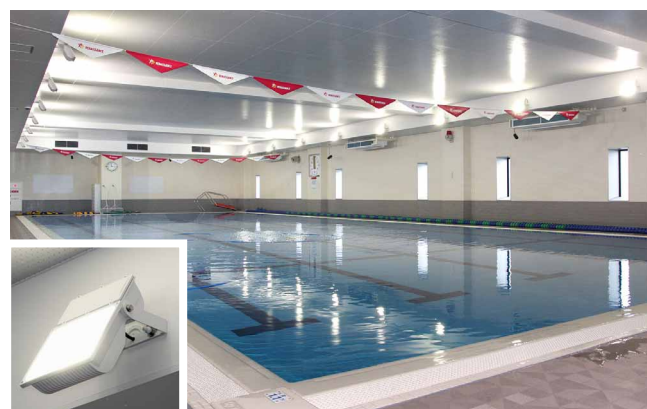
屋内プール用照明としてLED投光器DL-EL40Nも18台設置
