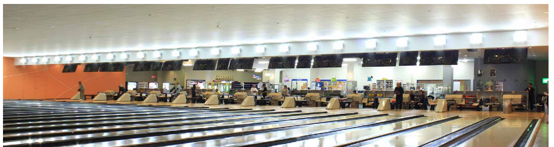
新しく導入されたLEDキャノピー灯(154W)
