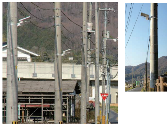
着々と町中に設置工事が進んでいるLED防犯灯
