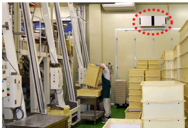
壁掛け型の採用で従来のパッケージ室での作業スペースを確保
