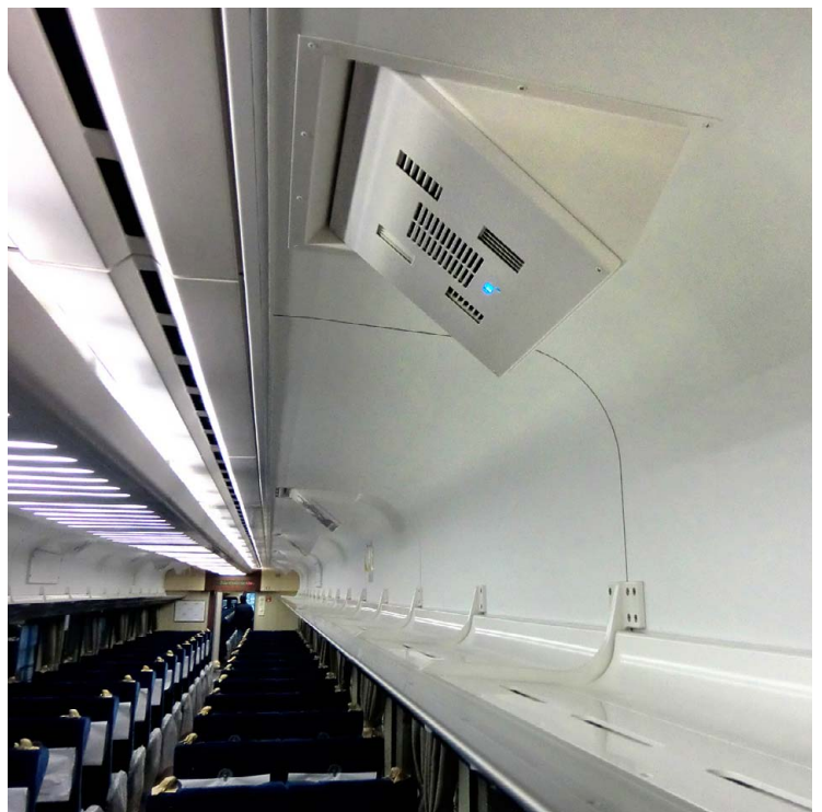
火災対策で金属のカバーを被せたオリジナル仕様で天井埋込型イオン発生機を設置 ※写真は整備中のものです。
