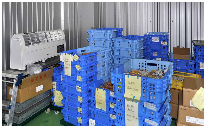
人の出入りの少ない冷蔵庫(保管室)にも設置
