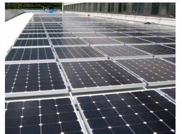
藤井地区 1号棟 1階屋上
