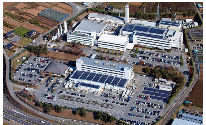
3,000枚以上の太陽光発電パネルが敷設された穂坂地区の工場
