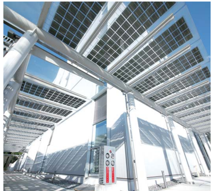
屋外渡り廊下に設置された結晶ライトスルー太陽電池
