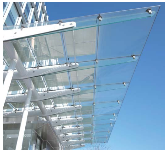
エントランスの大庇には、薄膜シースルー太陽電池を設置している。
