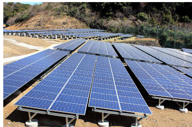
ゴルフ場という勾配の複雑な斜面に効率良く敷設された施工技術の高さにもお客さまから高い評価が集まっている
