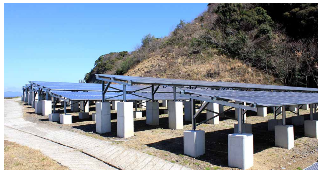
強風に耐えられるよう、自社で強固なコンクリートの基礎工事を施されている
