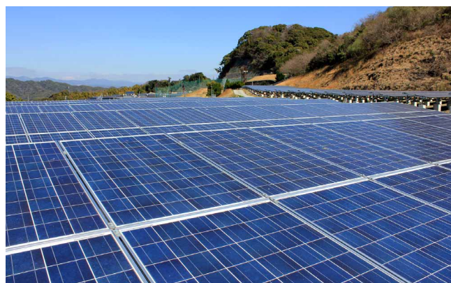
ゴルフ場跡地を活用してメガソーラーを建設。住宅地に隣接するため、連系できる高圧送電線が近く、初期費用が抑えられた
