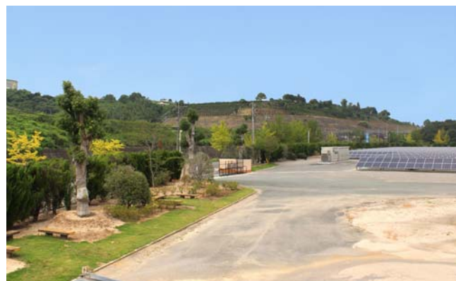
発電所を入った真正面には空き地を確保。今後、市内の中학생向けに太陽電池の仕組みを学べるパネル設置などを予定
