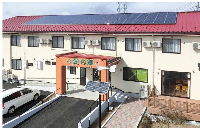
15.7kWの太陽光発電システムによる創エネで、環境にも配慮
