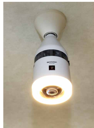
全居室トイレと共用トイレに天井設置型イオン発生機を設置。脱臭効果だけでなく、人感センサー付きLED照明で消し忘れも防止
