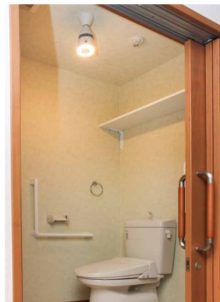
全居室トイレと共用トイレに天井設置型イオン発生機を設置。脱臭効果だけでなく、人感センサー付きLED照明で消し忘れも防止
