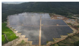
ベトナムに建設したメガソーラー発電所
